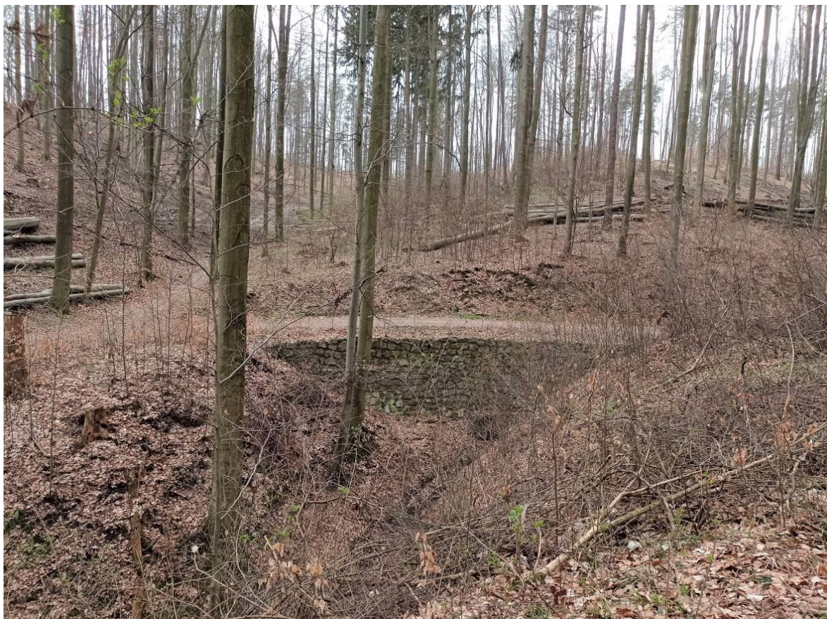
obr. 16 – lesní cesta Kroucená s opěrnou kamennou zídkou a trubním propustkem
