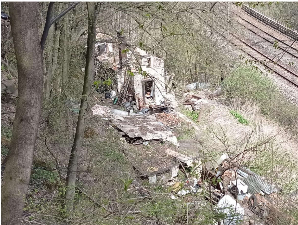
obr. 87 – ruina drážního domku a nehorázný svinčik v jejím okolí
