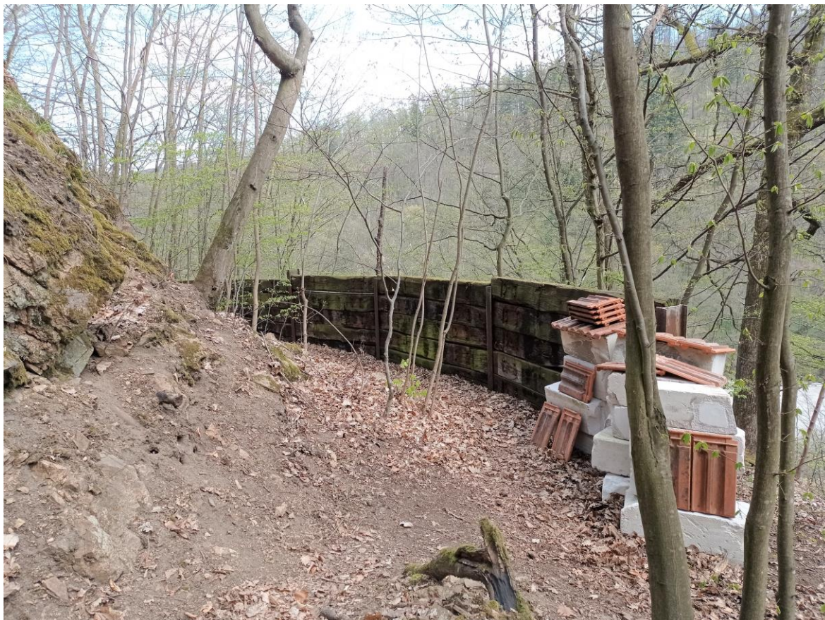
obr. 88 – ochranná pražcová bariéra a deponie stavebního materiálu
