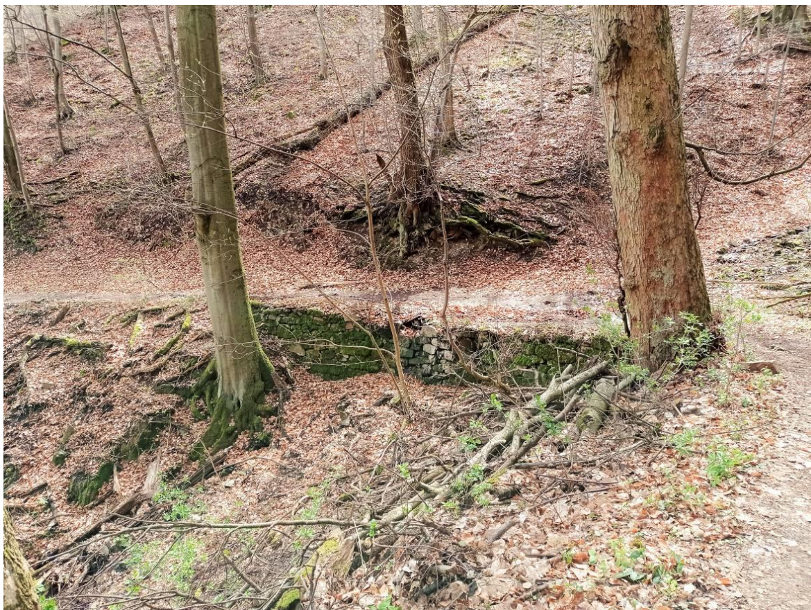
obr. 34 – pěšiny a cesty jsou pomístně zpevněny nasucho skládanými kamennými zídkami
