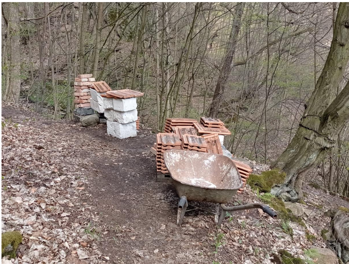
obr. 89 – další stavební materiál postupně přesunovaný k rozpadající se ruině
