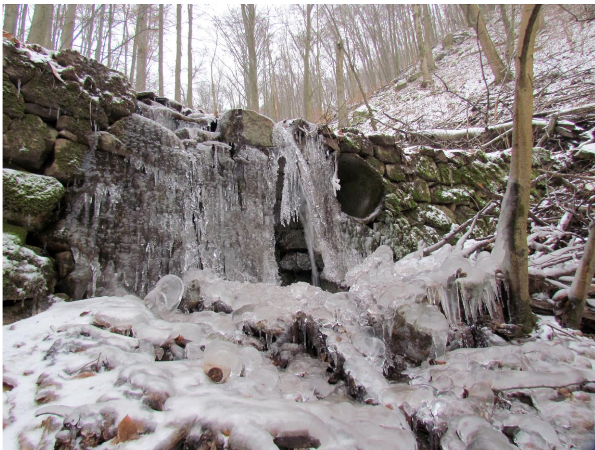
obr. 109 – zaledněné koryto potoka a nasucho skládaná kamenná zídka s propustkem
