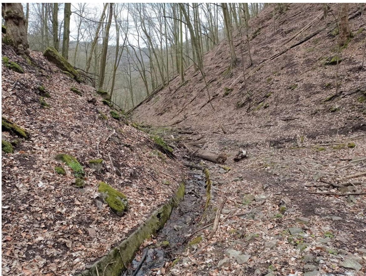
obr. 32 – koryto potoka Malužín zpevněné ve spodní části dožívajícími betonovými žlaby
