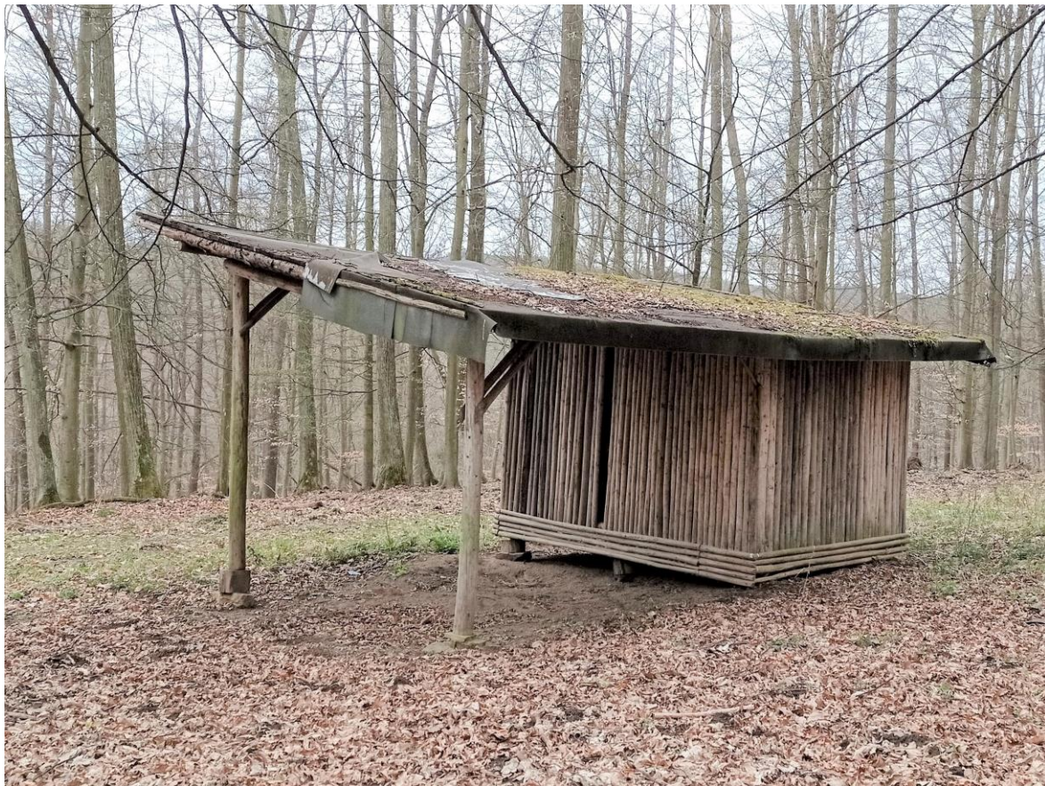
obr. 43 – zřejmě již nevyužívaný seník s krmelištěm v OP pod západním hřebenem
