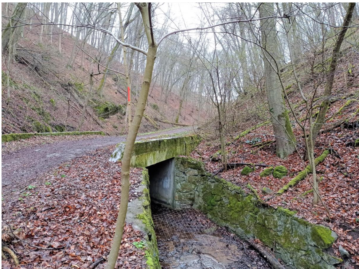
obr. 38 – betonové přemostění Útěchovského potoka na té samé cestě
