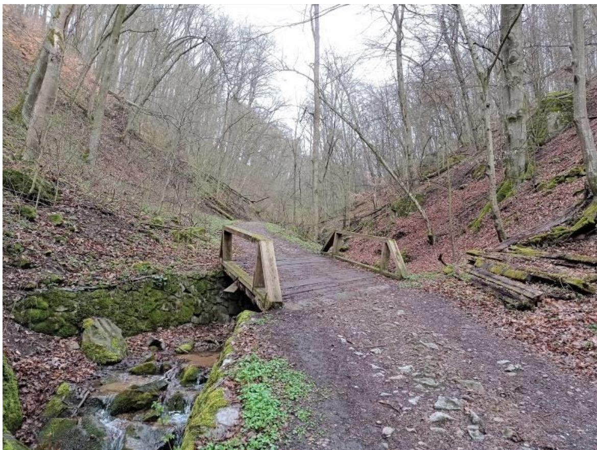
obr. 37 – dožívající dřevěný most na Gangloffově cestě
