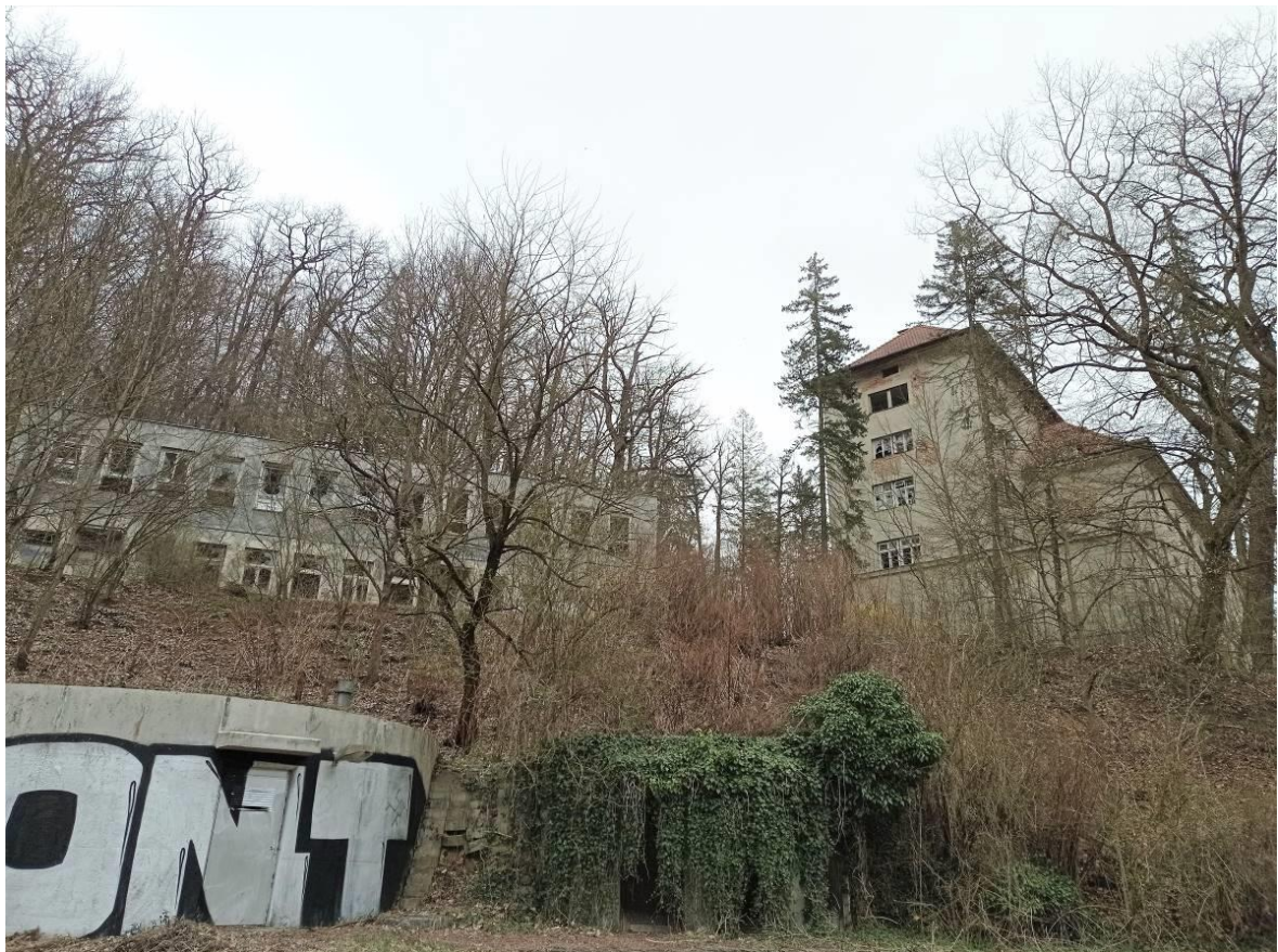
obr. 26 – opuštěné budovy v ochranném pásmu ZCHÚ devastují squatterři
