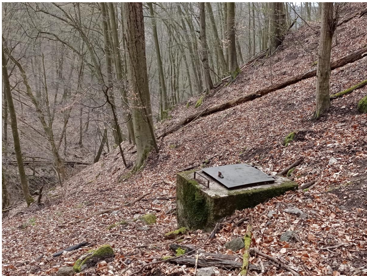
obr. 30 – některé vydatnější prameny jsou v ZCHÚ zachycené v betonových šachtách
