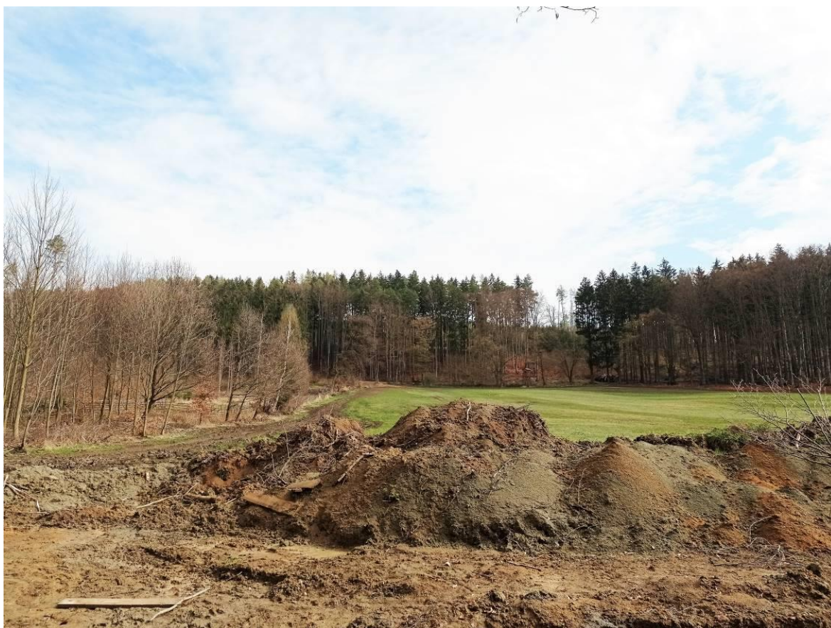
obr. 140 – po dokončení výkopových prací a uložení potrubí je třeba uvést pozemky do původního stavu
