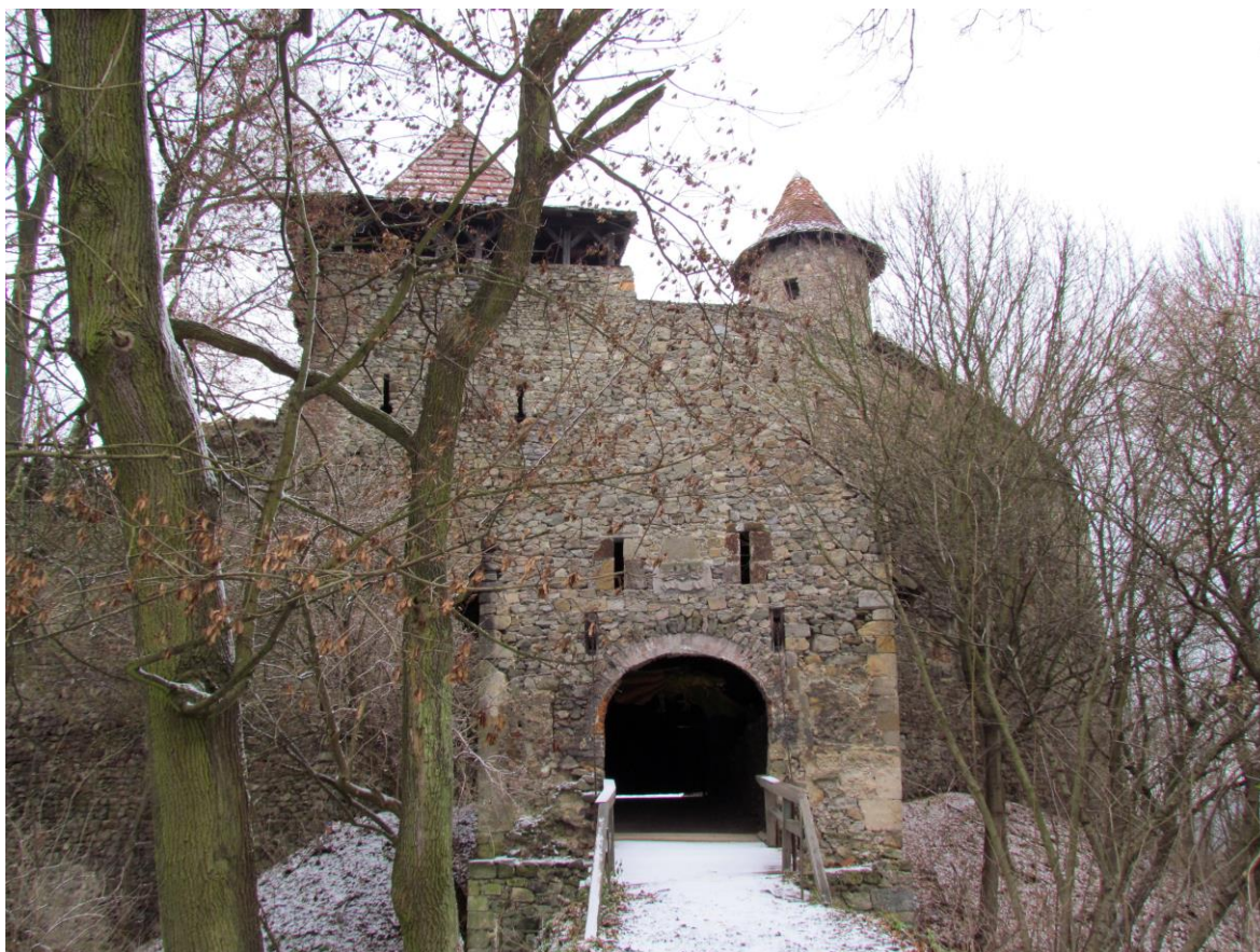
obr. 157 – vstupní brána s padacím mostem
