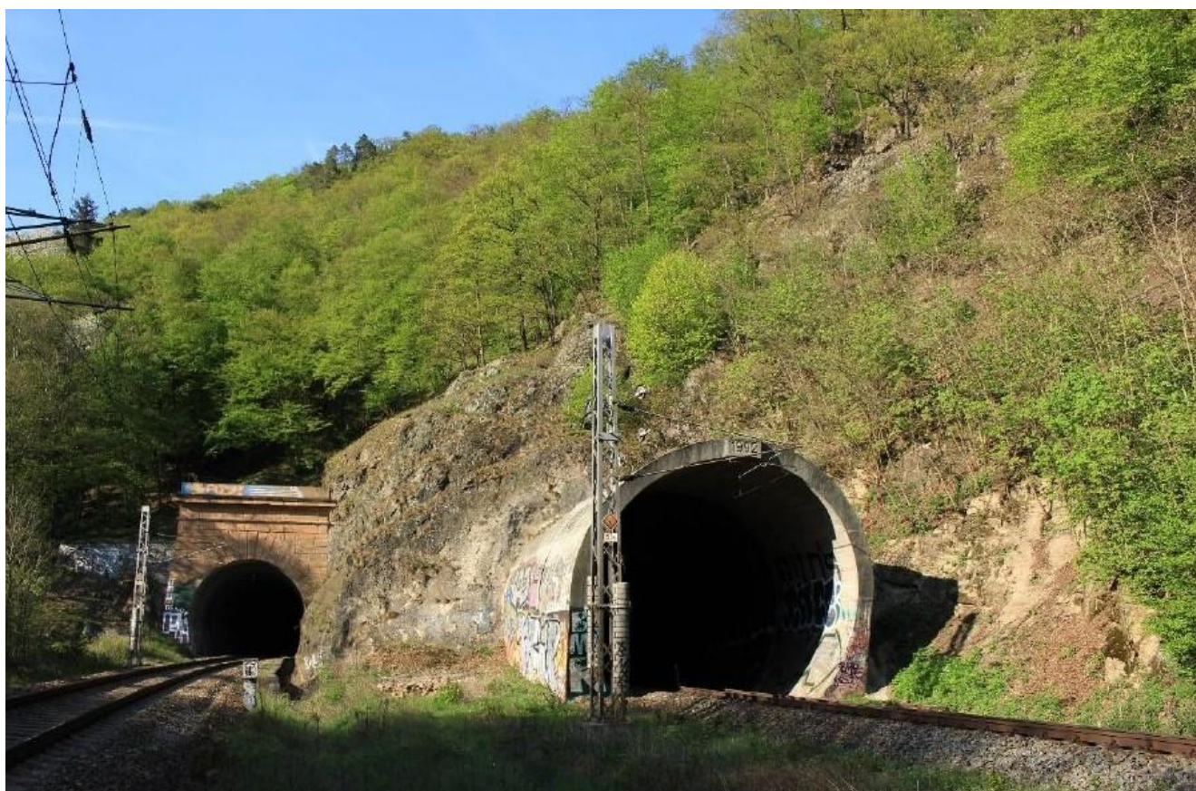
obr. 161 – památkově chráněný a vedle něj aktuálně přebudovávaný tunel v granodioritovém masívu pod Novým hradem
