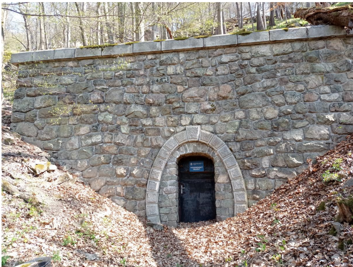
obr. 23 – historický vodárenský objekt v severní části ZCHÚ ve svahu pod Novým hradem
