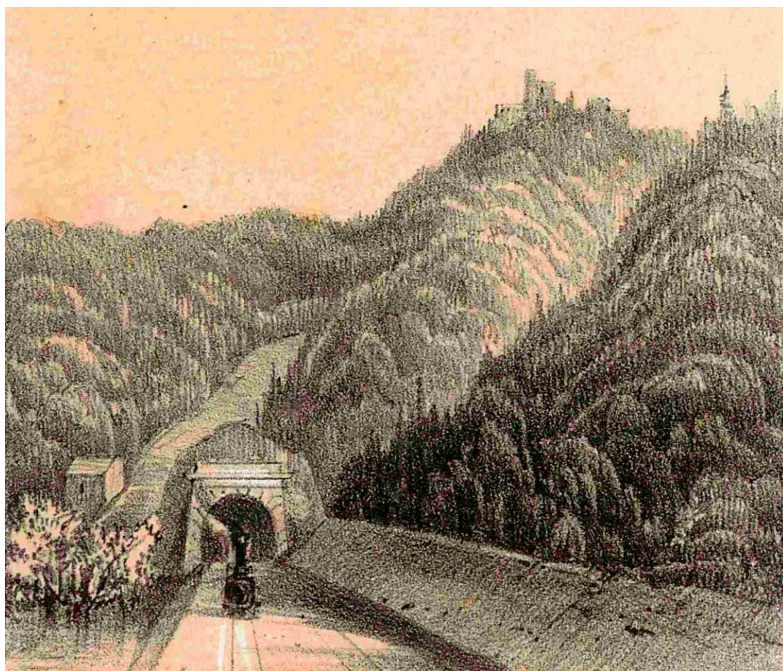
obr. 163 – tunel pod Novým hradem
